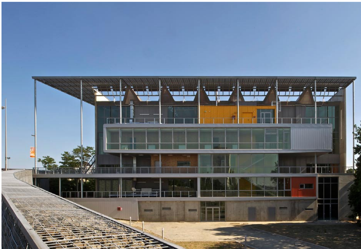
La façade Nord et ses coursives, à l'Ouest le mur en gabions
