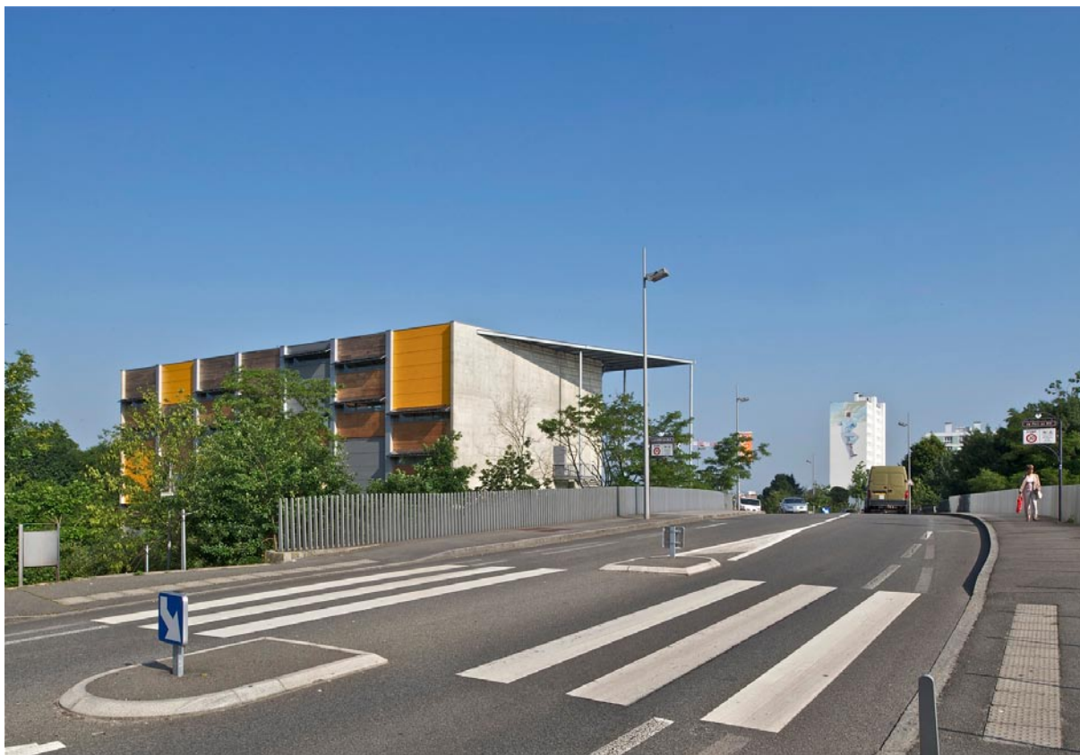
La façade Sud et ses brise soleil et le pignon adossé au boulevard
