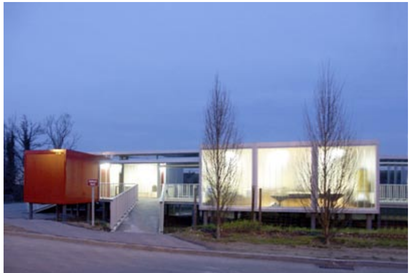
L'assemblage des modules s'effectue en trois jours
