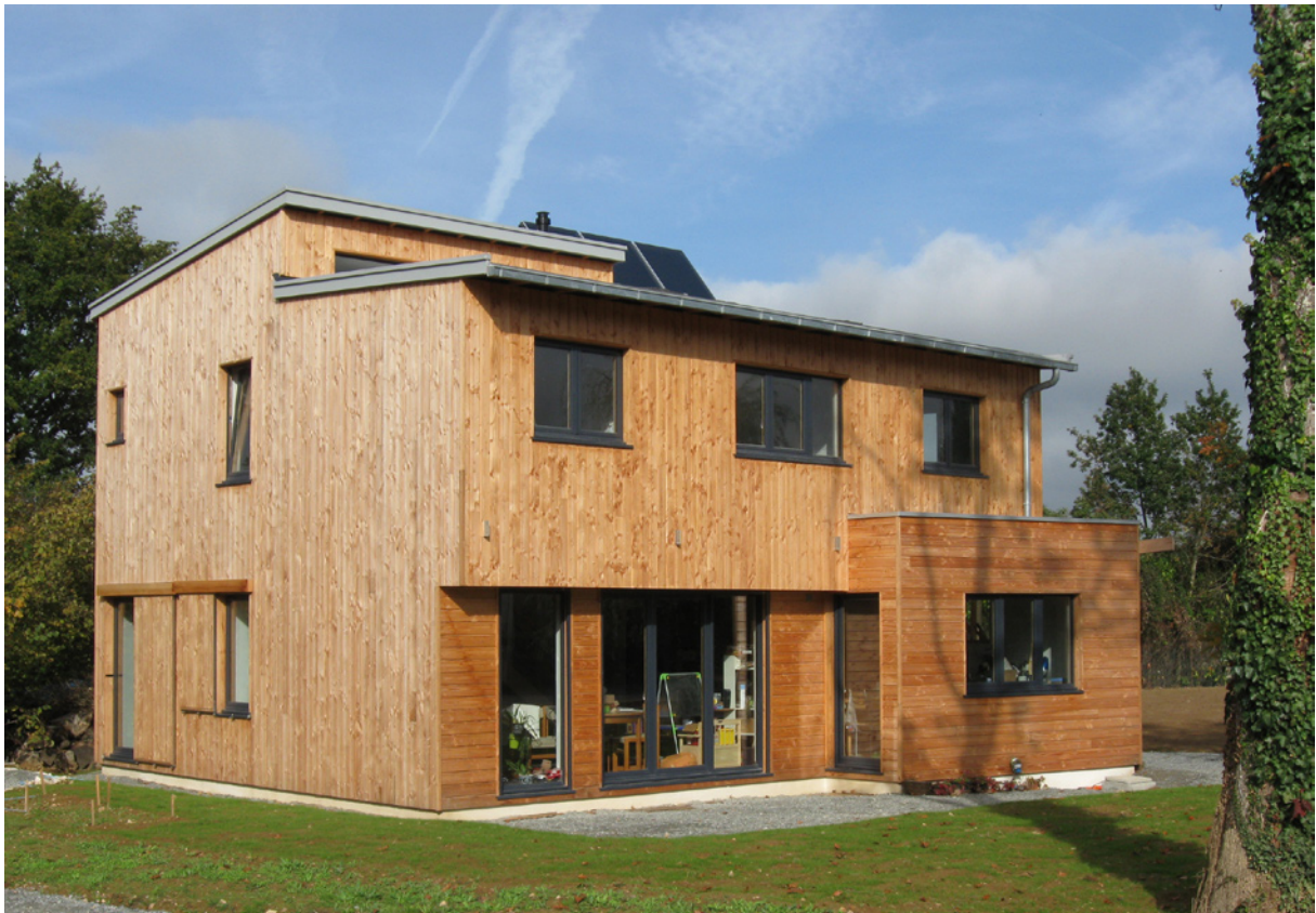
Façade Sud, sur rue
