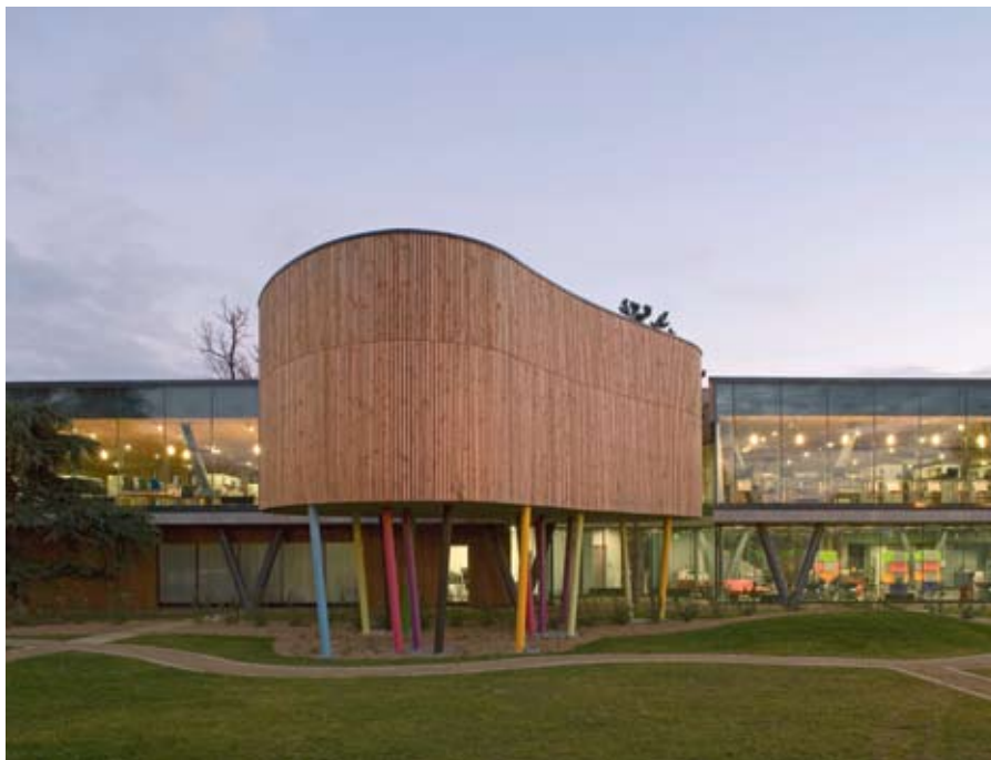
1 er PRIX D'ARCHITECTURE 2006 MÉDIATHÈQUE LUDOTHÈQUE RENÉ-GOSGINNY ET ESPACE JEUNESSE LE PATIO SAINTE-LUCE-SUR-LOIRE FORMA 6, architectes, Nantes
