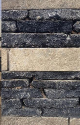
Phase chantier des deux projets différents qui mettent en œuvre la fabrication de murs en galettes d'enrobé pour créer un soutènement et une bande plantée, soit avec l'enrobé seul, soit intercalé avec des bordures plus claires, créant un jeu de contrastes
