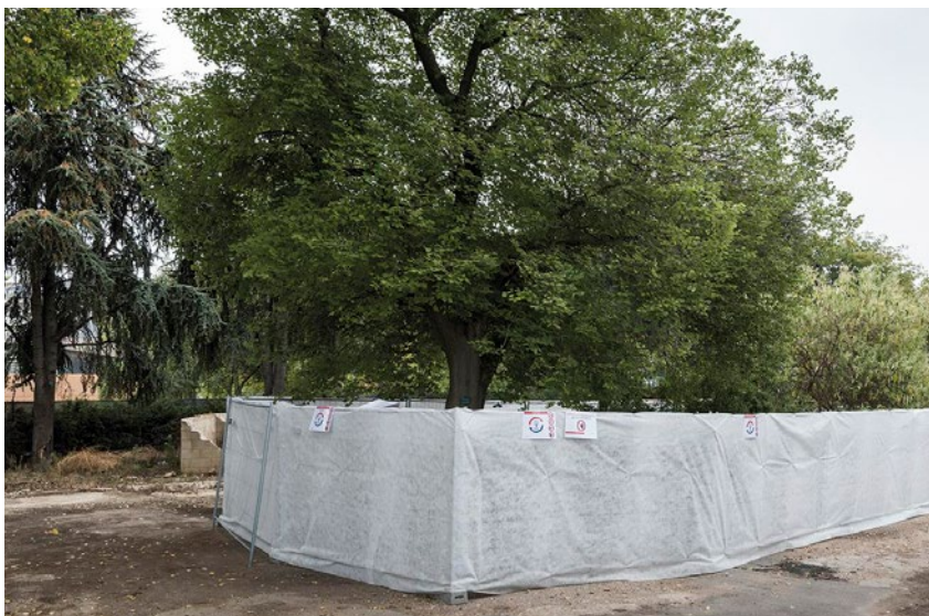
◀ Protection des arbres par clôture pendant un chantier
