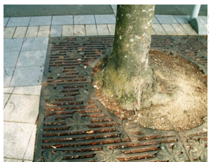
▲ Attention à bien centrer les arbres en milieu de fosses. Dans le cas présent, il y a un risque de blessure à court terme.
