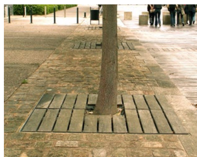
▲ Dans cet espace urbain très circulé, les plaques de bois protègent du piétinement. Mais dès que c'est possible, préférer des massifs de pleine terre.
